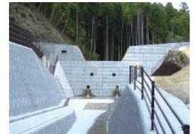
広島市においては、ここ20年間で何度も発生する土砂災害に対して100基以上の砂防ダムが建設されています。砂防ダムというのは上流から流入してくる土砂を貯留するために、あるいは既に河床に堆積した土砂の流出を防止するためのダムのことをいいます。
